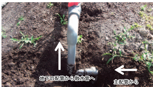
写真4 地下配管からの立ち上がり
