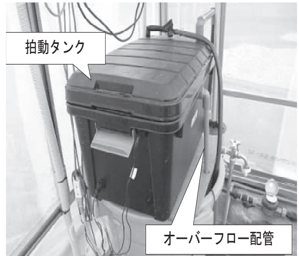
第7図 拍動タンクへのオーバーフロー配管の取付
