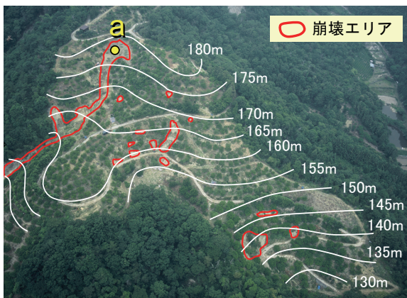
第5図 園地Cの斜面崩壊の状況
