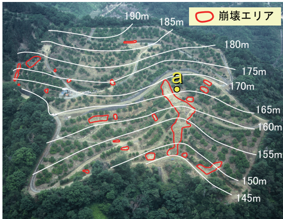
第4図 園地Bの斜面崩壊の状況
