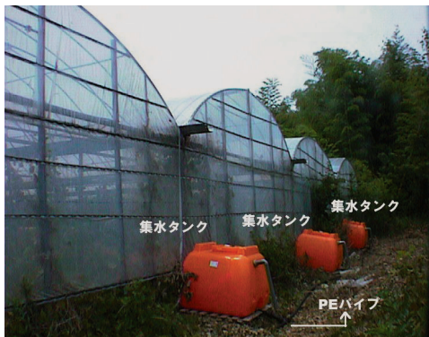
写真4 ハウス下の集水用タンク
