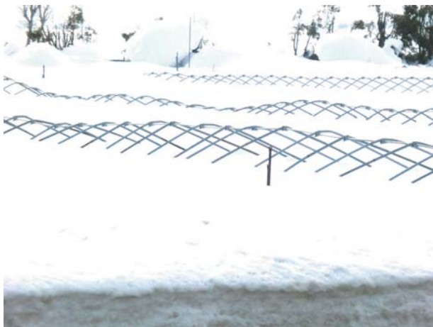
写真5 ハウス骨組みの肩を超えた積雪の様子 (美幌市周辺)
