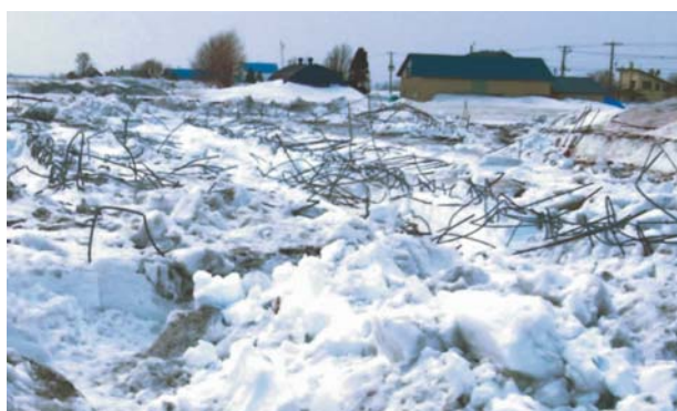
写真1 倒壊したハウス（岩見沢市周辺，農研機構小南靖弘氏 提供）
