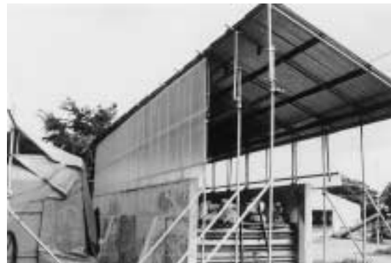
写真 17 試験バンカーサイロに設置した屋根 Photo 17 Roof attached to test bunker silo
