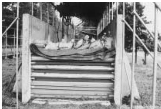
写真 26 搬入口と取り出し口に設置した仕切り板 Photo 26 Partition boards attached to bunker silo
