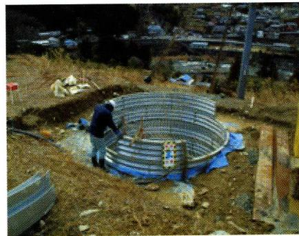
写真1 地すべり地帯での集水井設置
