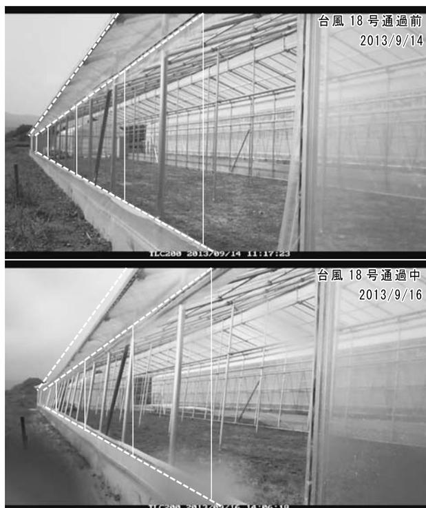
写真3 台風18号の強風による変位（上写真：2013年9月14日11：17，下写真9月16日14：06）
