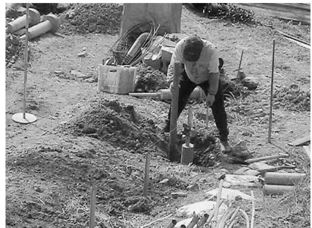
写真11 主基礎の埋設作業
