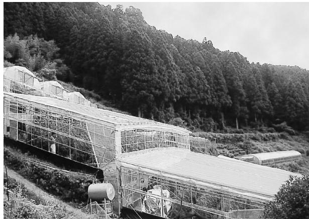
写真9 段畠地形に対応した平張型傾斜ハウス
