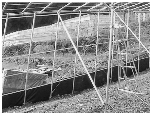
写真13 ブレースおよび筋交い補強
